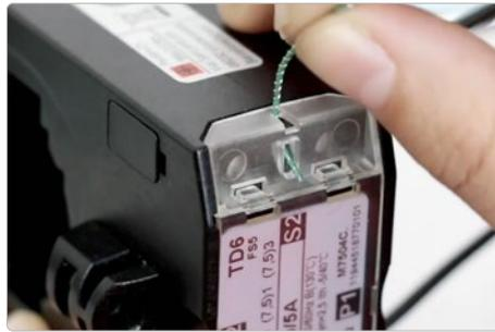
Le scellement du transformateur est réalisé une fois le couvercle couvre-bornes en place.
