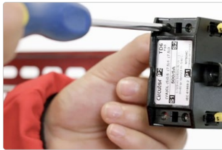
Conectar los cables del secundario.
